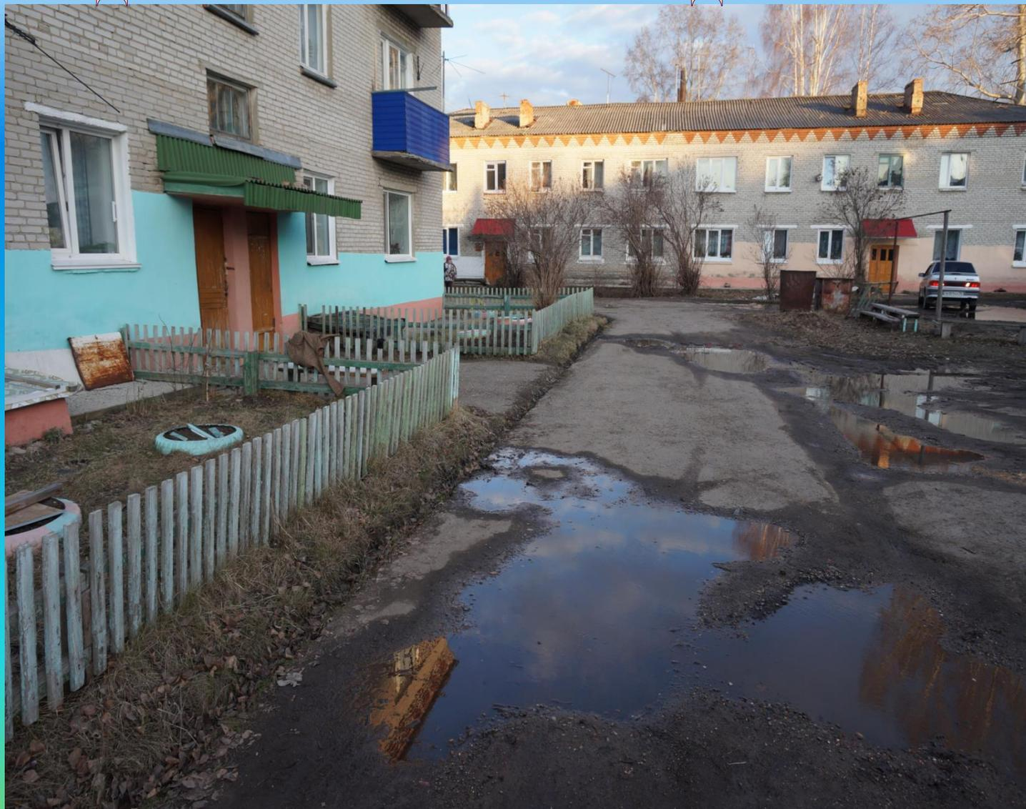
ИМЕЮТСЯ МНОЖЕСТВЕННЫЕ ТРЕЩИНЫ АСФАЛЬТОВОГО ПОКРЫТИЯ;
